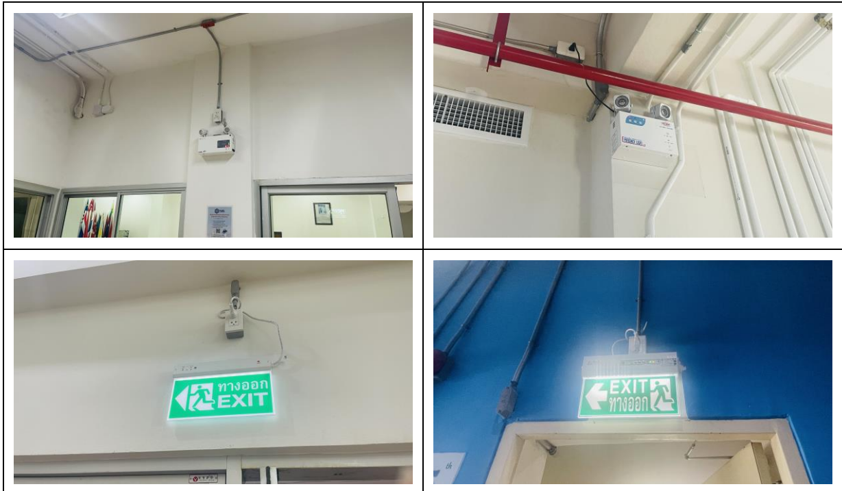
รูปที่ 10 ไฟฉุกเฉิน และป้ายทางออก
